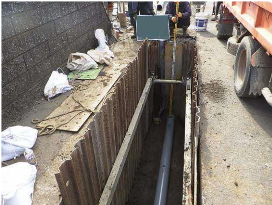
【未普及地域における污水管路*整備】 污水管路*整備
