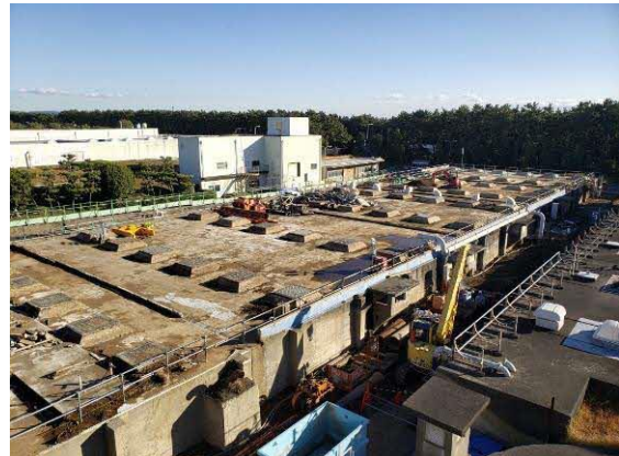
【汚濁負荷削減対策】 辻堂浄化センター 雨水滞水池* (既存躯体解体)
