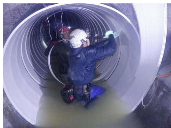
【管路の耐震化 * 】 管更生 *
