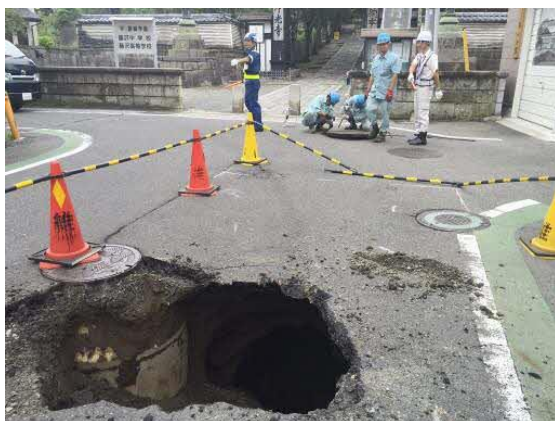
【管きよ*老朽化に起因する道路陥没】
