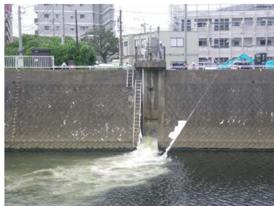
【ポンプ場*故障による未処理下水の河川流出】
