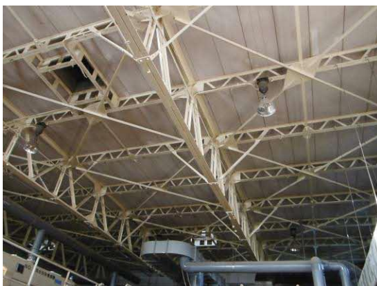
【施設の耐震化 * 】 藤が谷ポンプ場 ブレース * 設置
